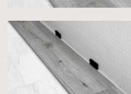
Lasciare la distanza di 8 mm su tutto il perimetro del locale e da qualsiasi ostacolo che comprometta il movimento della pavimentazione. Terminata la posa rimuovere i distanziatori e posizionare idoneo battiscopa. Non fissare a terra il battiscopa.
